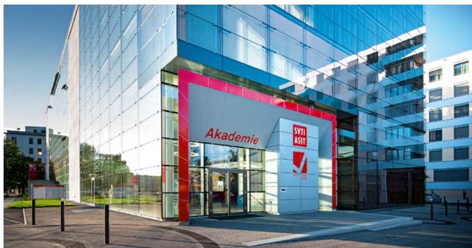
Der Hauptsitz der Swiss Safety Center AG in Wallisellen beim Bahnhof.
