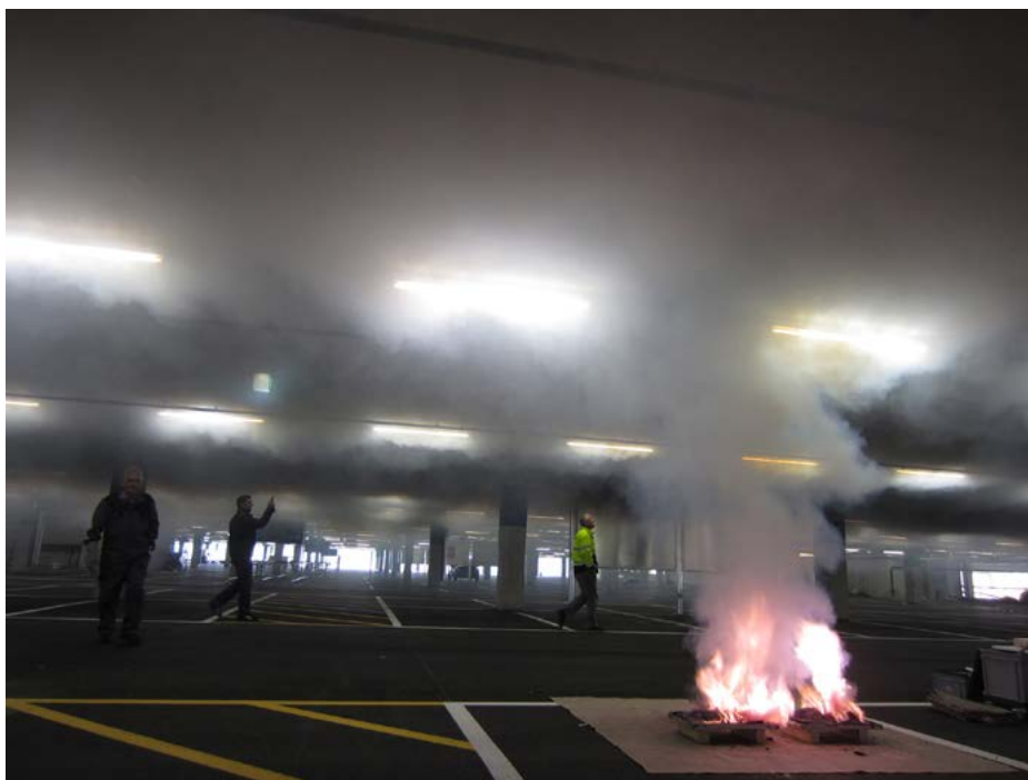
Test der Entrauchung in einem Parking.
