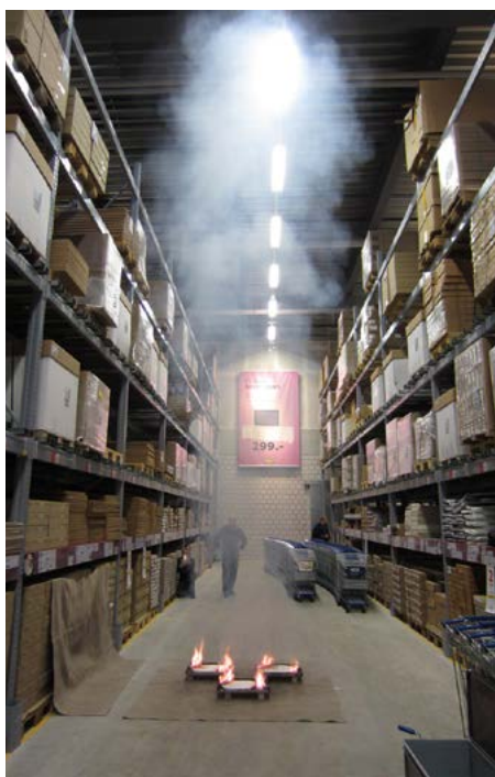
Test der Entrauchung in einem bekannten Verkaufshaus.
