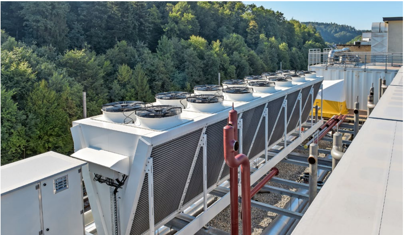
Doppelstapel-Trockenkühler
